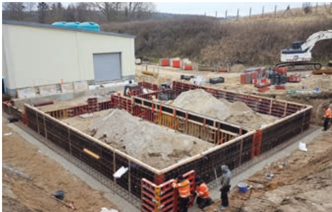
Budowa nowego zbiornika wody czystej w stacji wodociągowej Laage służy zwiększeniu bezpieczeństwa dostaw wody w Meklemburgii-Pomorzu Przednim
